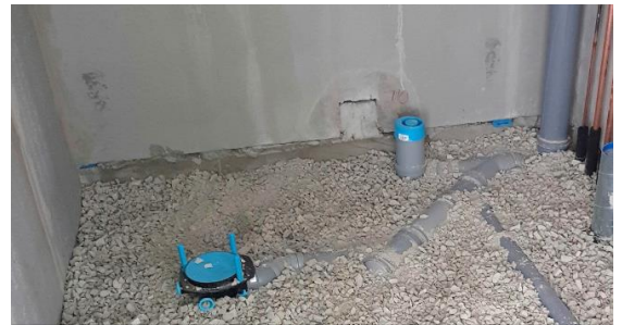
Kevytsora korvattu vähemmän pölyävällä vaahtolasimurskalla.
