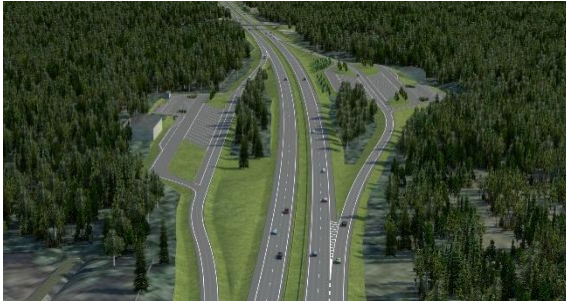
E18 Hamina-Vaalimaa motorway PPP project
